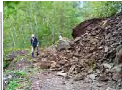
9月17日前日の大雨で林道が崩落しバスから降りてダム地点まで1時間歩く
