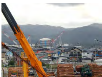
大間港から建設中の大間原発を見る
